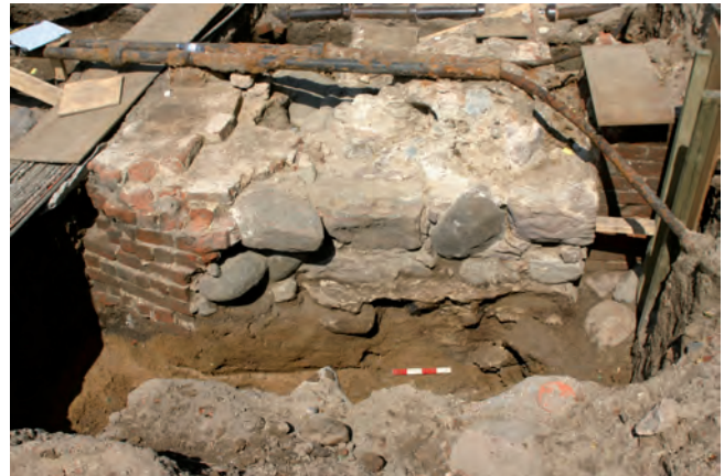
Fig. 12: Overgangen mellem kor og skib i kirkens sydmur opført i kamp. Felt 1, set fra S. (Foto: Kirstine Haase/Morten Larsen).
