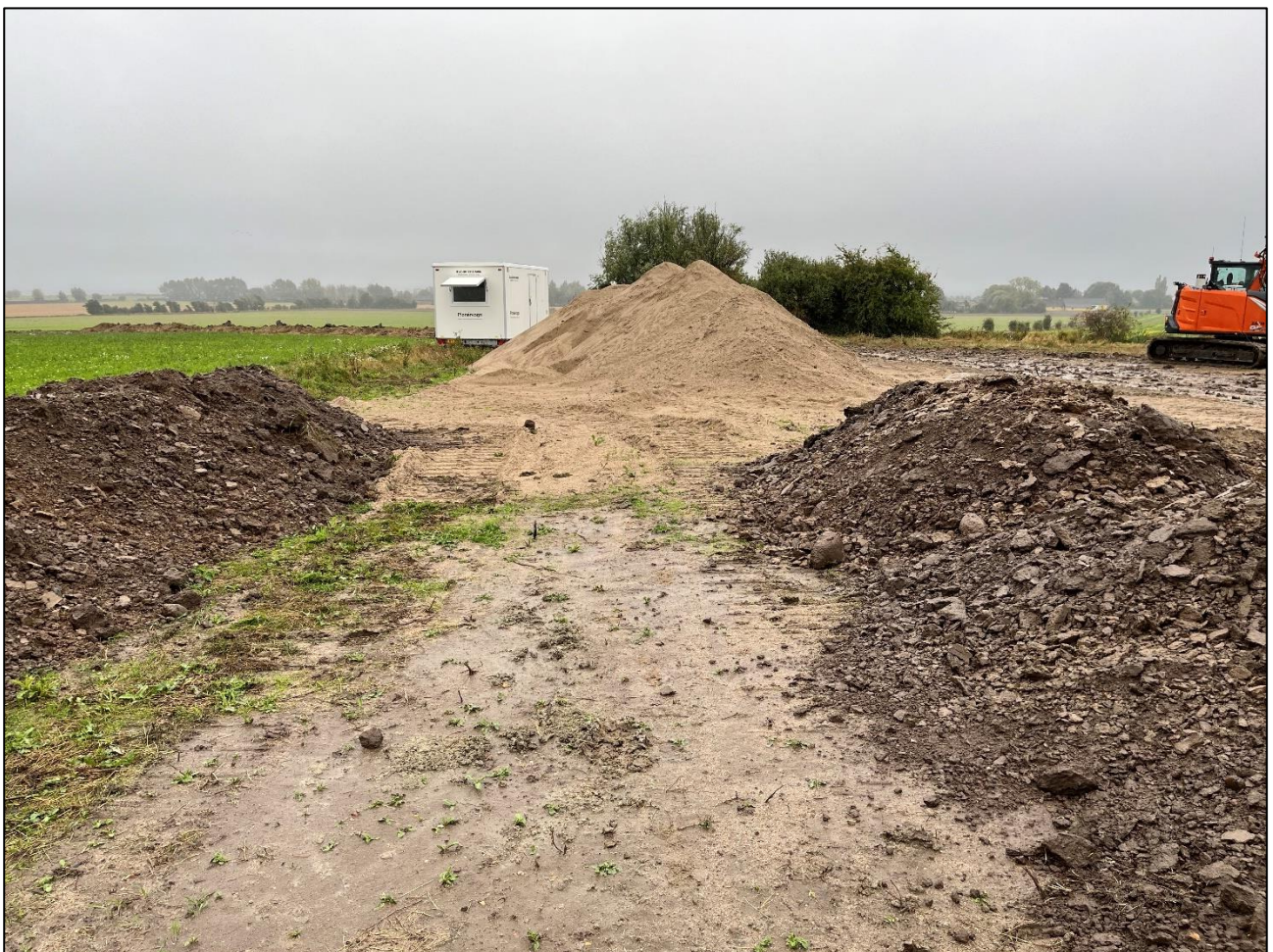
Grusbunke og skurvogn blokerede den sydligste del af arealet.
